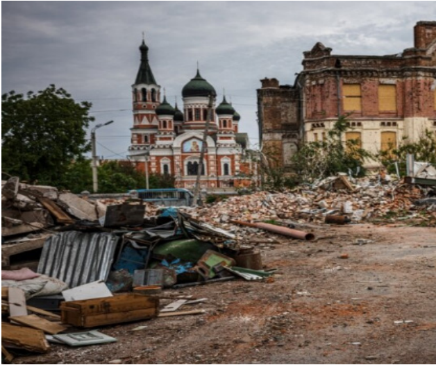
Рис. 3. Фото пошкоджених будівель м. Харкова
